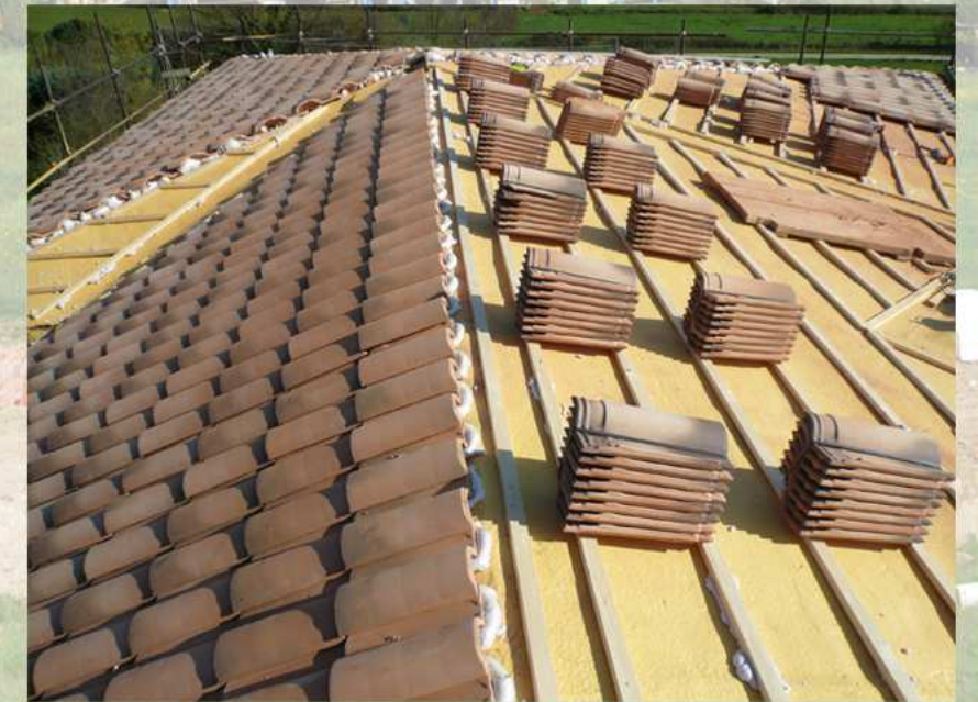
ISOLAMENTO TERMICO IN SCHIUMA POLIURETANICA E TETTO VENTILATO
